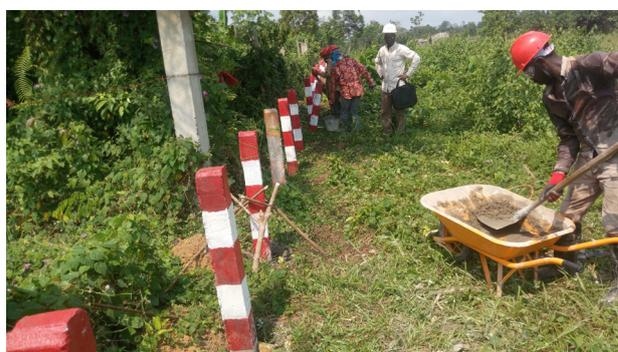
Travaux d'installation d'indicateurs des limites de l'emprise du Pipeline au village Ebome
